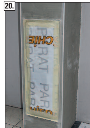
20. Beispiel für bauseitige Schutzabdeckung.
