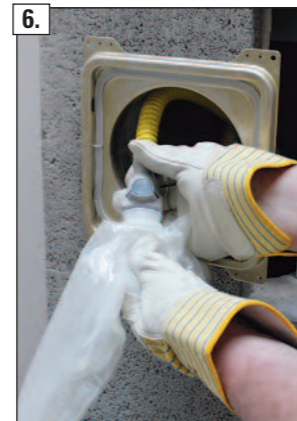
6. Kondensatauffangbeutel mit Kupplungsteil verbinden.
