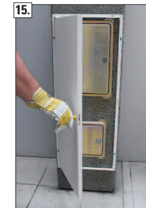
15. Kunststoffkeile entfernen und Funktionskontrolle der Tür durchführen.
