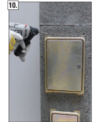
10. Zuerst nur die beiden oberen und unteren Befestigungslöcher vorbohren.
