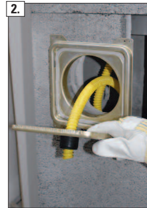
2. BlowerDoor-Kondensatblindentürblatt abnehmen und Adapter für HT-Rohrverbindung DN40 mit Siphonschlauch herausziehen.
