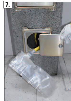
7. Austausch der BlowerDoor-Kondensatblende mit Öffnung gegen eine geschlossene BlowerDoor-Kondensatblindentür.
