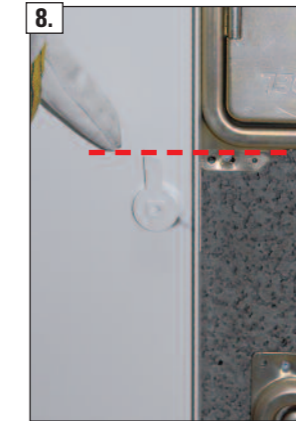
8. WICHTIG! Verschlusshebel im Türblatt darf nicht zu hoch positioniert werden damit dieser nicht am Putzrahmen anschlägt.
