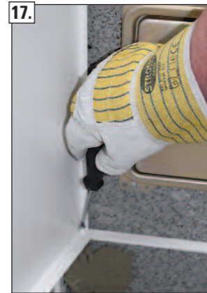
17. Untere Schanierschraube am Türblatt lösen.
