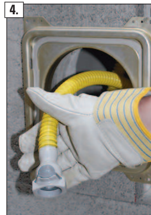
4. Kupplungsteil des Kondensatauffangbeutels auf den 3/4" Siphonschlauchaufstecken.
