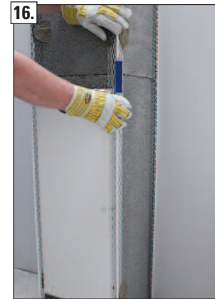
16. Putzschienen mit Ansetzplomben ausrichten. ACHTUNG! Lackierung dabei nicht beschädigen.
