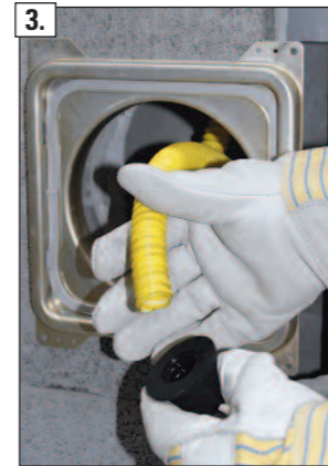
3. Adapter für HT-Rohrverbindung DN40 vom Siphonschlauch abschrauben.
