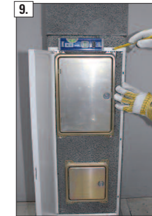
9. Blendenrahmen lotrecht ausrichten.
