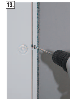
13. Erst jetzt, im zweiten Arbeitsschritt, die beiden mittigen Bohrlöcher vorbereiten.
