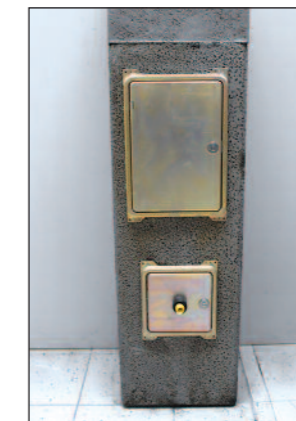
Ansicht des werkseitigen Auslieferungszustandes mit Anschlussöffnung nach vorne und BlowerDoor-Kondensatblendentür mit Anschlussöffnung.
