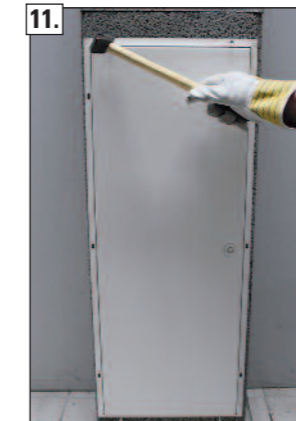
11. Schlagdübel in die beiden oberen und unteren Befestigungslöcher einsetzen und einschlagen.
